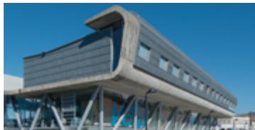
Situé au bord de la mer, ce bâtiment semble braver les assauts de la mer et avoir été modelé par le vent. Une structure sinueuse en béton en définit la toiture (sous laquelle se reposent les bateaux) et une très vaste façade de verre laisse totalement pénétrer la lumière naturelle.
