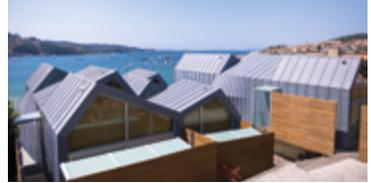
La forme de ces logements évoque les coques inversées de trois bateaux. Les constructions sont tournées vers la ria et revêtues de zinc. La façade et le toit ne font qu'un et les pièces sont complètement ouvertes sur le paysage.
